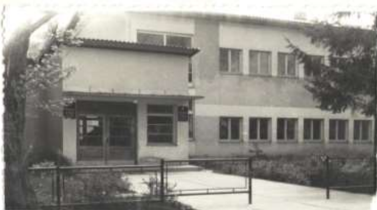
Novi školska zgrada iz septembra 1965. god.
